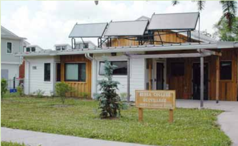
Solar Arrays at the Commons House
